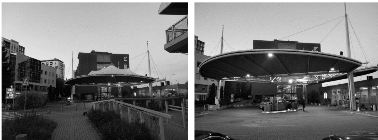
Fig. 5, Fig. 6. Strukturalna konstrukcja przekrycia zadaszzenia, urozmaicona zespoleniami stalowych skratowań na stacji paliw dla samochodów w Gdyni.
