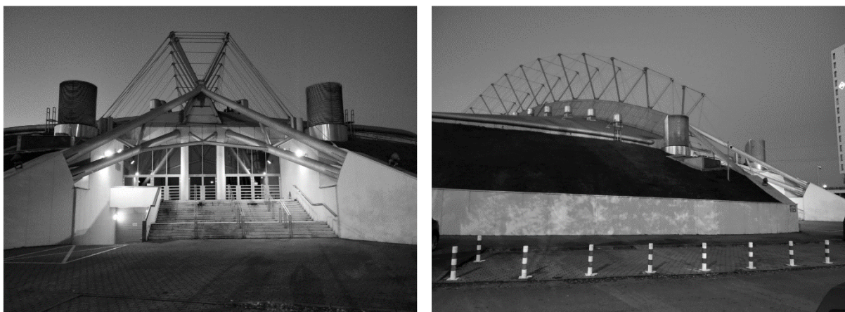
Fig. 3, Fig. 4. Hala sportowa w Gdyni, jej centralna oś łuku głównego jego wyniesienie wraz z rytmem masztów.
