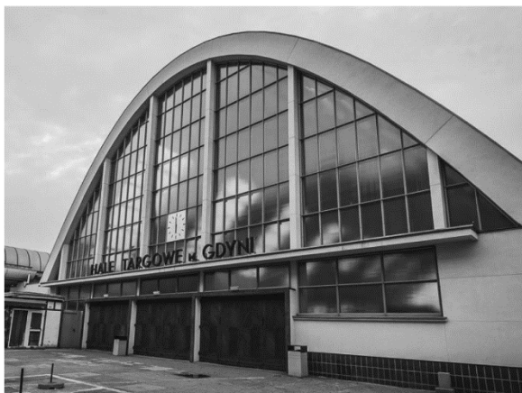
Fig. 1, Fig. 2. Paraboloidalne kształty na elewacjach i w konstrukcjach dachowych Hali Targowej w Gdyni i Pomorskiego Parku Naukowo-Technicznego w Gdyni.
