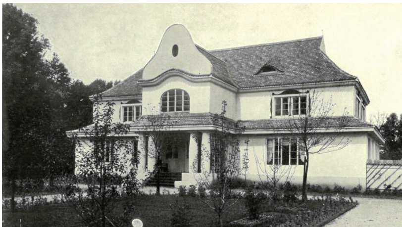
Ryc. 1. Dworek wybudowany wg projektu Józefa Czajkowskiego na Wystawie Architektury i Wnętrz w otoczeniu ogrodowym
