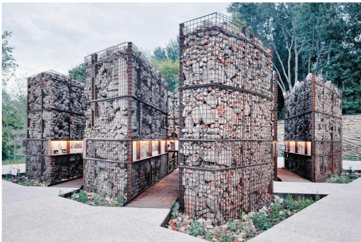
Ryc. 1. Przykład konstrukcji wykonanej z gruzobetonu. (Park Akcji "Burza" Warszawa). Fot. Michał Szłaga
